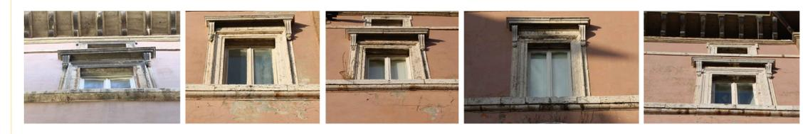
D4 PROSPETTO 1 (PBS: P06.E07.01.PR1) DETTAGLIO CORNICE FINESTRA SECONDO PIANO (DEGRADO C) rif. keymap 1:20
