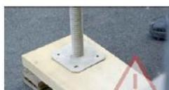
REALIZZARE UNA BASE DI APPOGGIO STABILE TENENDO CONTO DELLE CARATTERISTICHE DEL TERRENO E DI EVENTUALI AREE SFONDABILI / NON PORTANTI
