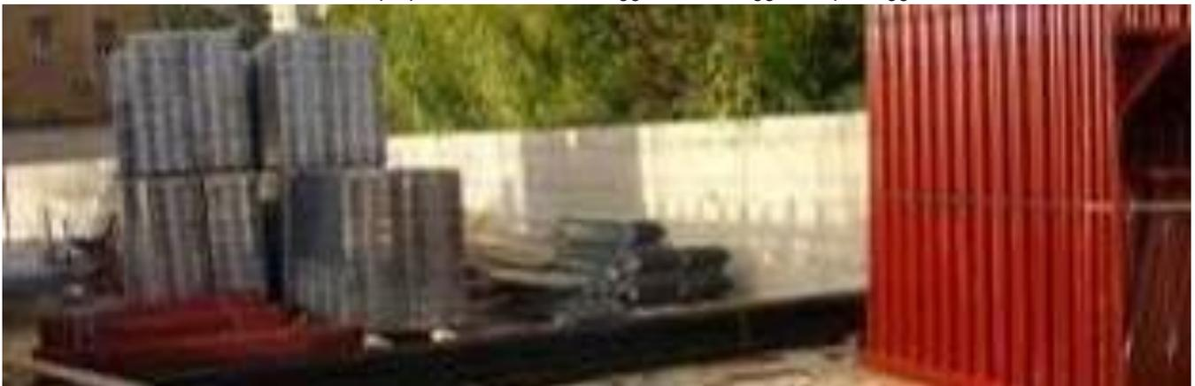
Modalità di Stoccaggio elementi del ponteggio di cantieri similari
